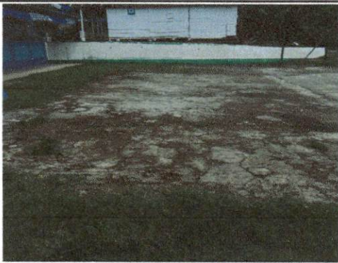
Foto 3: Reparación de planchas de concreto de patio T=.08
