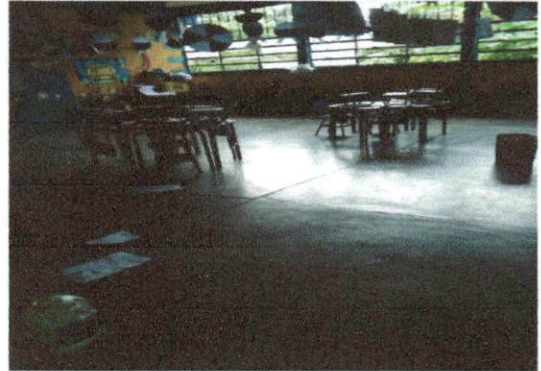
Foto 2: Sustitucion de piso de cemento liquido por piso de granito
